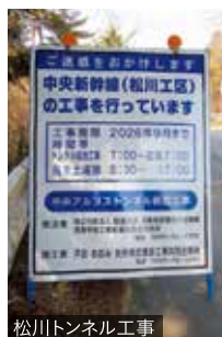
松川トンネル工事
