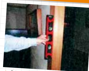
▲水平器による柱の傾きの計測
