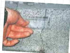
▲クラックスケールによる基礎のひび割れの計測
